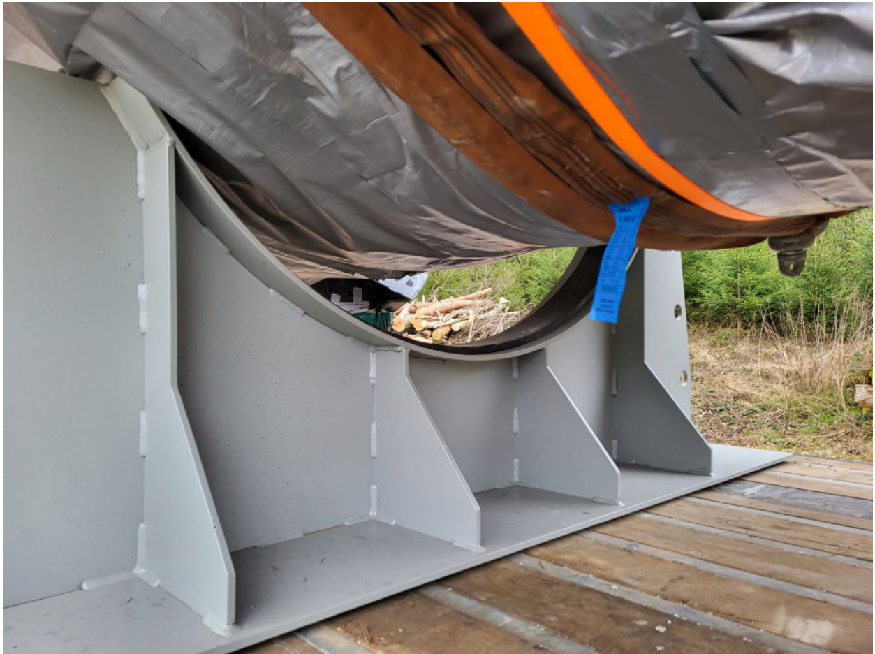
Abbildung 3: Eigentlich soll die Fischbauchklappe auf zwei Ständern sicher aufliegen. Doch die Ständer, die die Transportfirma extra gefertigt hat, passen nicht. Am Ende stabilisieren Holzbohlen das tonnenschwere Stahlteil auf seiner Reise nach Hannover und Berlin. Foto: Wasserwirtschaftsamt Traunstein
