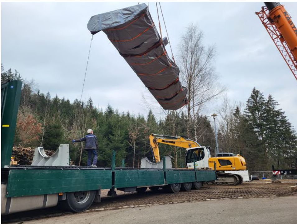
Abbildung 2: Am langen Ausleger des Krans schwebt die in Folie verpackte Fisch- bauchklappe hinauf zum Transporter. Foto: Wasserwirt- schaftsamt Traunstein
